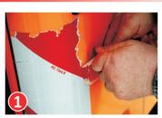
Stark haftende Folien werden mit einem Heißluftgebläse oder Dampfgerät gelöst und mit dem Spezialspachtel entfernt.
